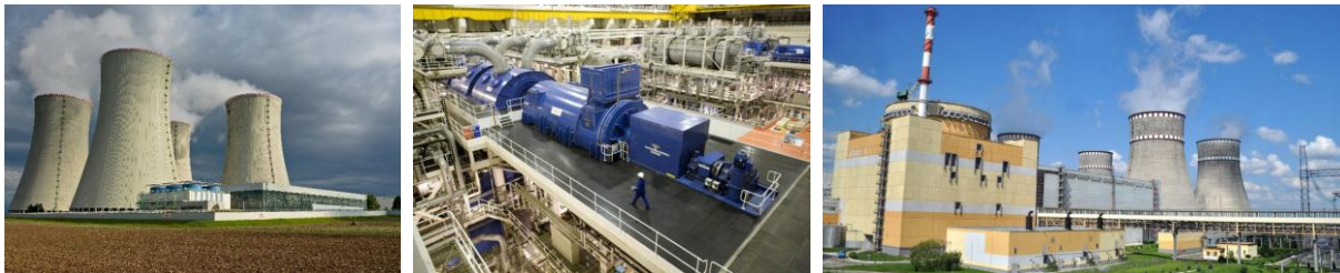
FIG. 12 Centrales nucléaires : tours de refroidissement, salle des machines, vue d'ensemble.
