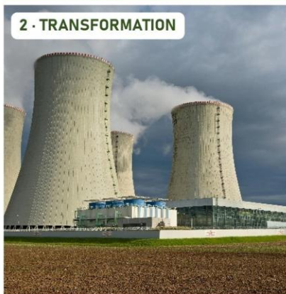
La centrale électrique
